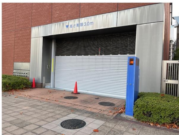
地下駐車場入り口（地上1階）
