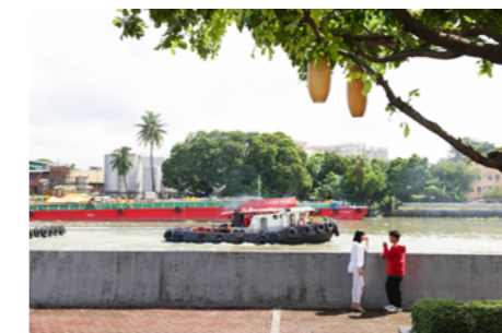
パッシング・マリキナ川河川改修事業(フェーズII)(円借款)で整備された河川堤防
