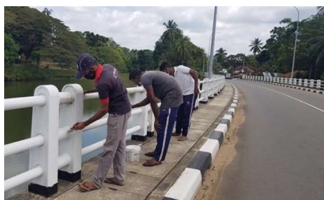
手すりの再塗装（デナガマ橋）
