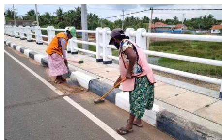
橋面の掃除（アルクリ橋）
