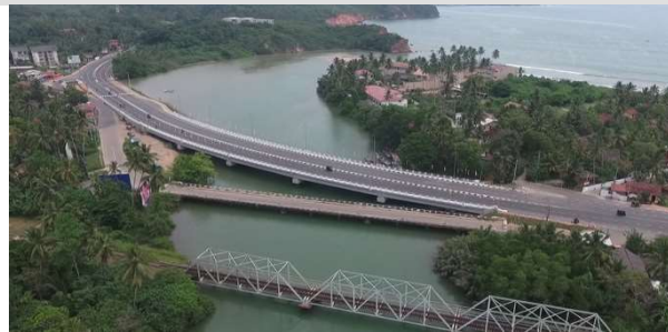
ポルワトゥモダラ橋（南部州マータラ県）
