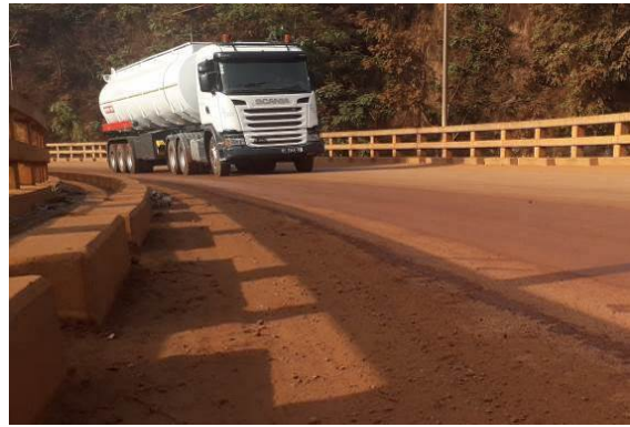
新しいカアカ橋を走るトレーラー（下り線）
