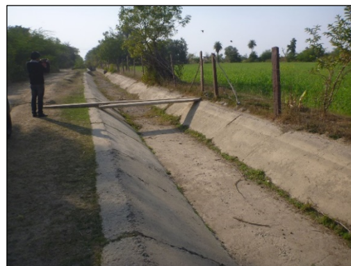
清掃された水路（本事業対象区間）
