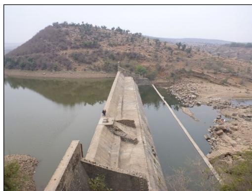
本事業が改修を行ったダム
