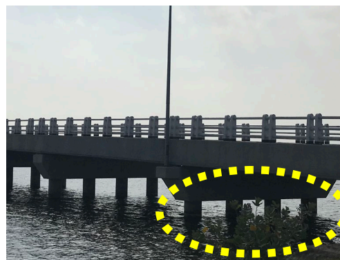
マンムナイ橋梁のパイルベント部分
