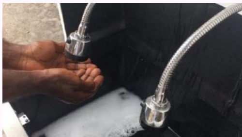
自動で石鹸と水が出てくる蛇口
