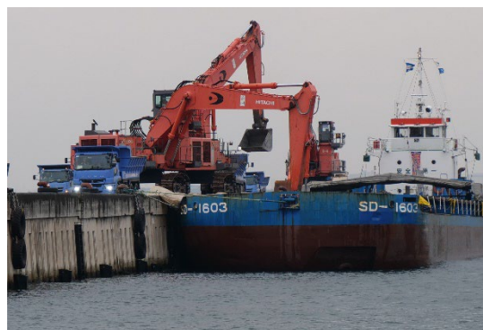
写真 2-11 船からトラックへの廃棄物の積替作業(大阪沖埋立処分場)
