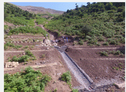
河川を通じて湿原に流入する土砂を抑制するため流域上流部山地にて対策工建設をパイロット事業で実施
