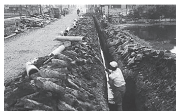
上水道の建設 (1960年代) 出典: 川口市ホームページ
