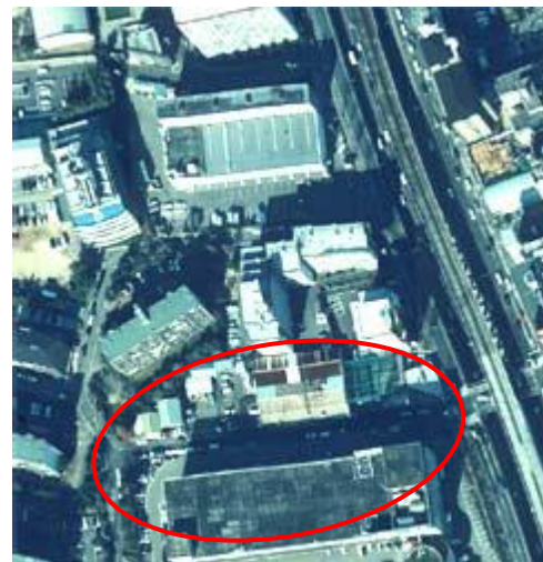
建物の局所歪み（空中写真の例）
