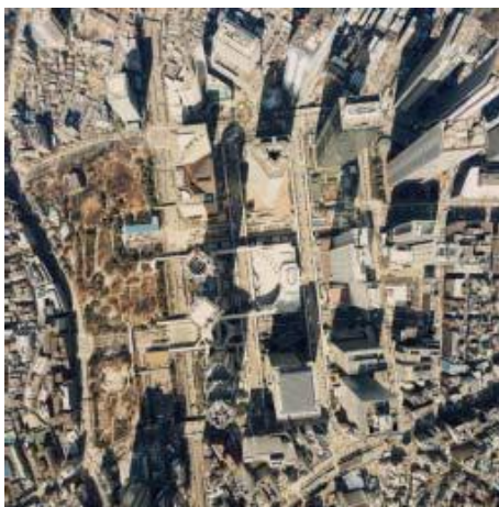
比高差による建物の倒れ（空中写真の例）
