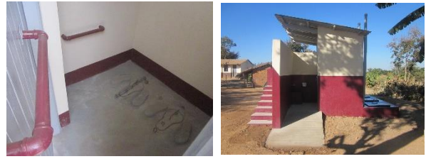
扉内側と壁に設置された手すり
