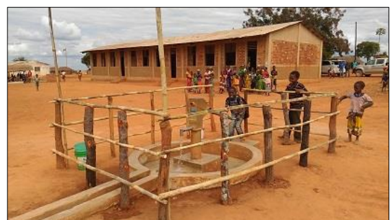
プロジェクトで建設された ハンドポンプ付き深井戸給水施設
