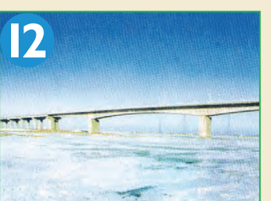
12 营口市供水项目
