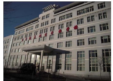
本事業で建設した青海大学医学院基礎医学教学楼
