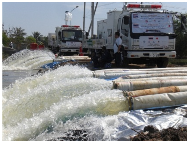
【写真】 タイ洪水災害における排水ポンプの活動現場
