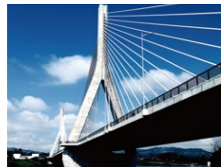
Projet de construction d'un pont sur le Nil (Ouganda) Photo : The Zenitaka Corporation
