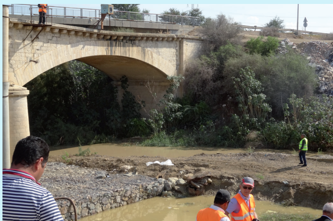
Projet de Contrôle des Inondations de Grand Tunis
