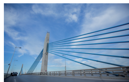
Vue sur le pont
