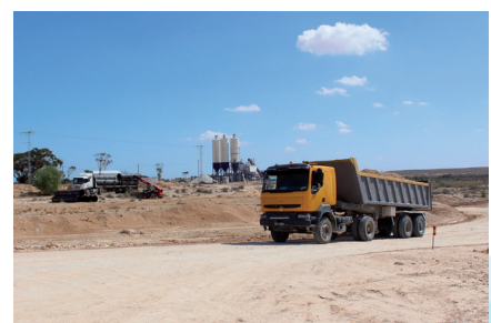
Travaux de terrassement à côté de l'une des installations de chantier
