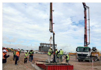
Travaux de construction de l'une des fondations profondes JICA ©/ Anis MILI
