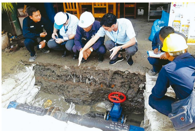
水道管へのバルブと流量計の取り付けを学ぶ職員
