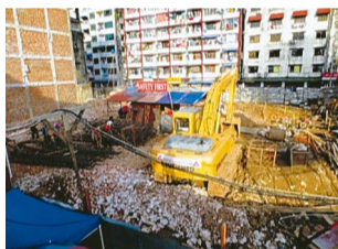
ヤンゴンのあちこちで建て替え工事を行っています
