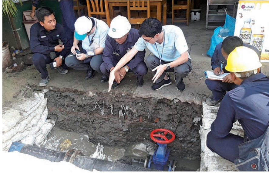
バルブと流量計を水道管に取り付ける正しいやり方を学ぶ職員
