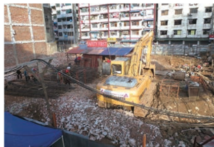
発展するヤンゴンの中心部。あちこちで建て替え工事などが進む
