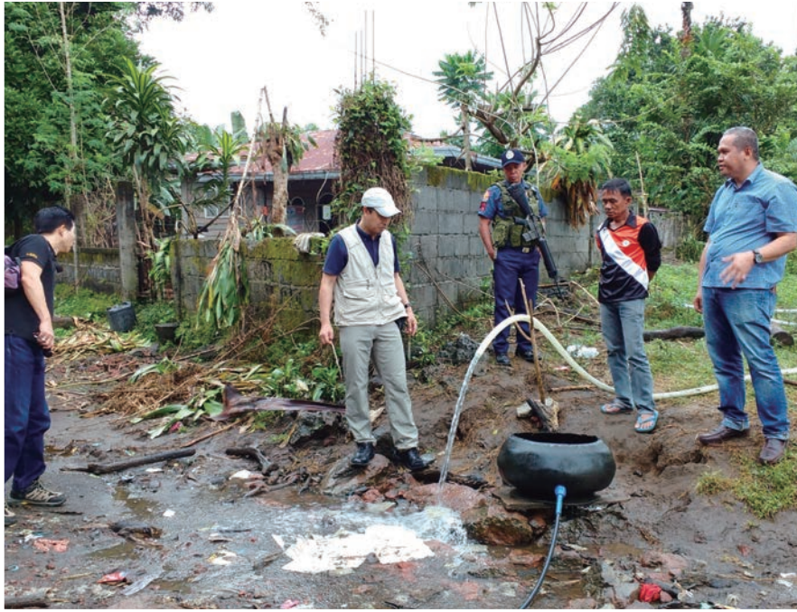
町長と住民が町役場近くの給水施設を紹介
