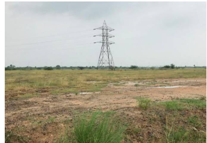
双日マザーソン工業団地内110kV変電所及び関連送電線の建設予定地(カンチプラム)
