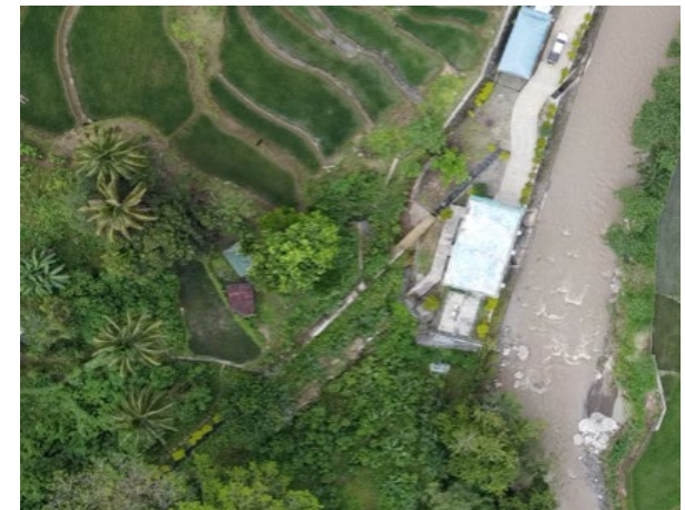
建設されたリクッド小水力発電所
