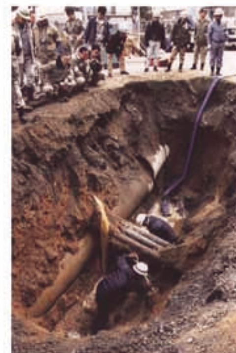
ライフラインの復旧作業 （神戸新聞社提供）
