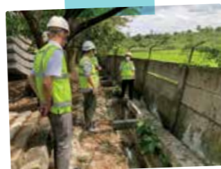
インフラ被害状況調査
