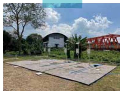
軟弱地盤でのポーラスコンクリート 製品性能試験の様子
