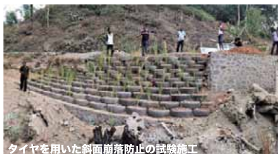
タイヤを用いた斜面崩落防止の試験施工
