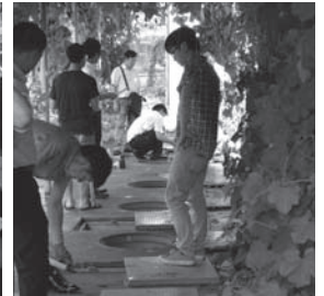
浄化槽の現状調査
