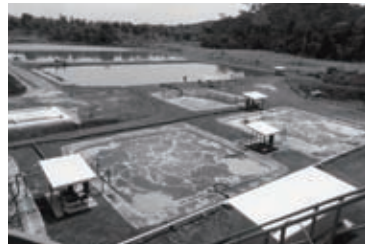
実証試験予定地となる工場排水処理施設
