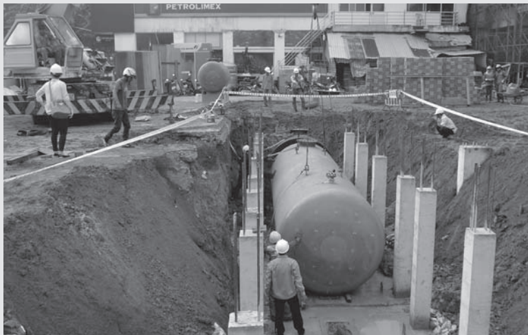
普及・実証事業でのSF二重殻タンク埋設見学会(ホーチミン)
