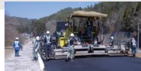
再生アスファルトを活用した舗装
