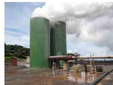
ラス・バイラス2の掘削現場。地下深部から熱水や蒸気を取り出し、発電のエネルギー源として使う。
