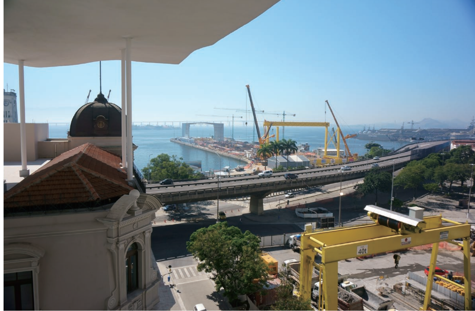
2014FIFAワールドカップを控えて、工事が進むリオデジャネイロ
