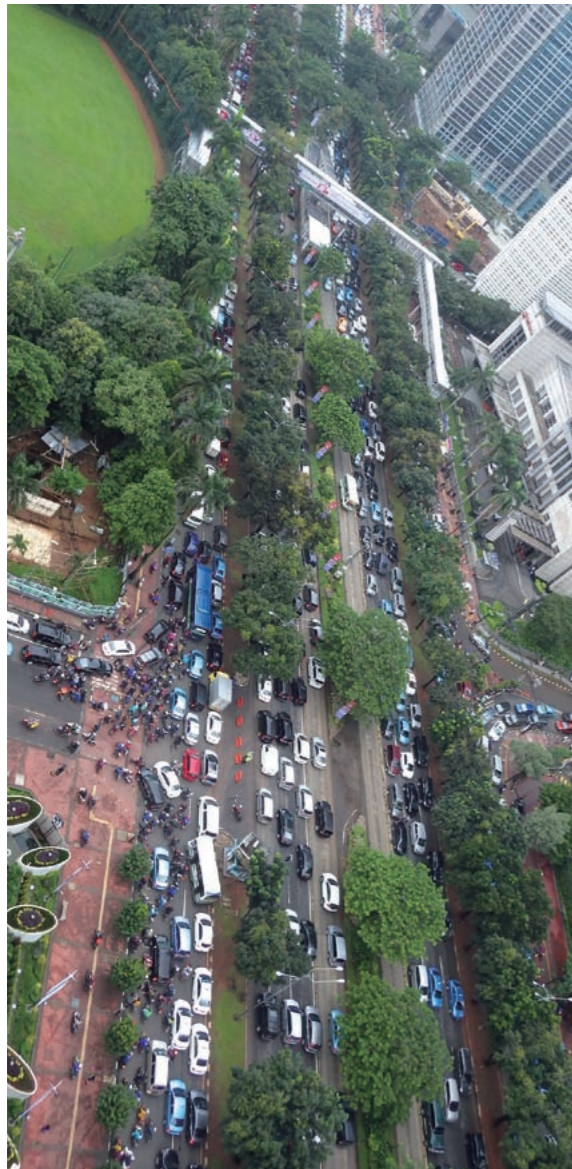
渋滞に悩まされているジャカルタの中心部、ステイルマン通り。この下を横断して下水道管を設置する工事を進めている
