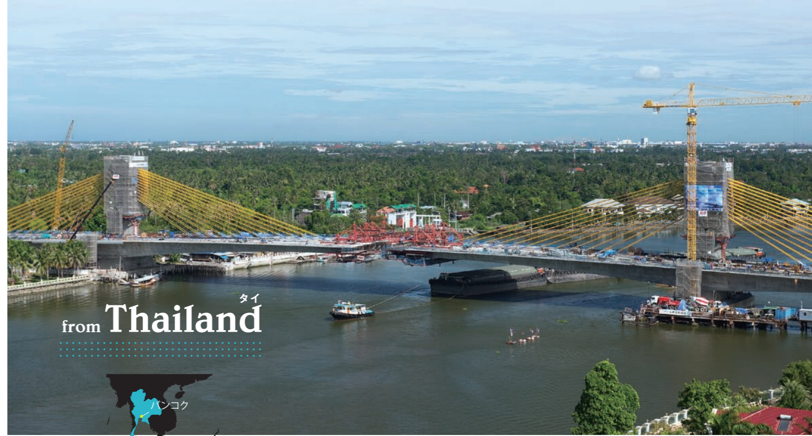
現在、建設が進められているチャオプラヤ川に架かる橋。新しく取り入れられたエクストラードロード橋の建設技術は日本が最先端だ
