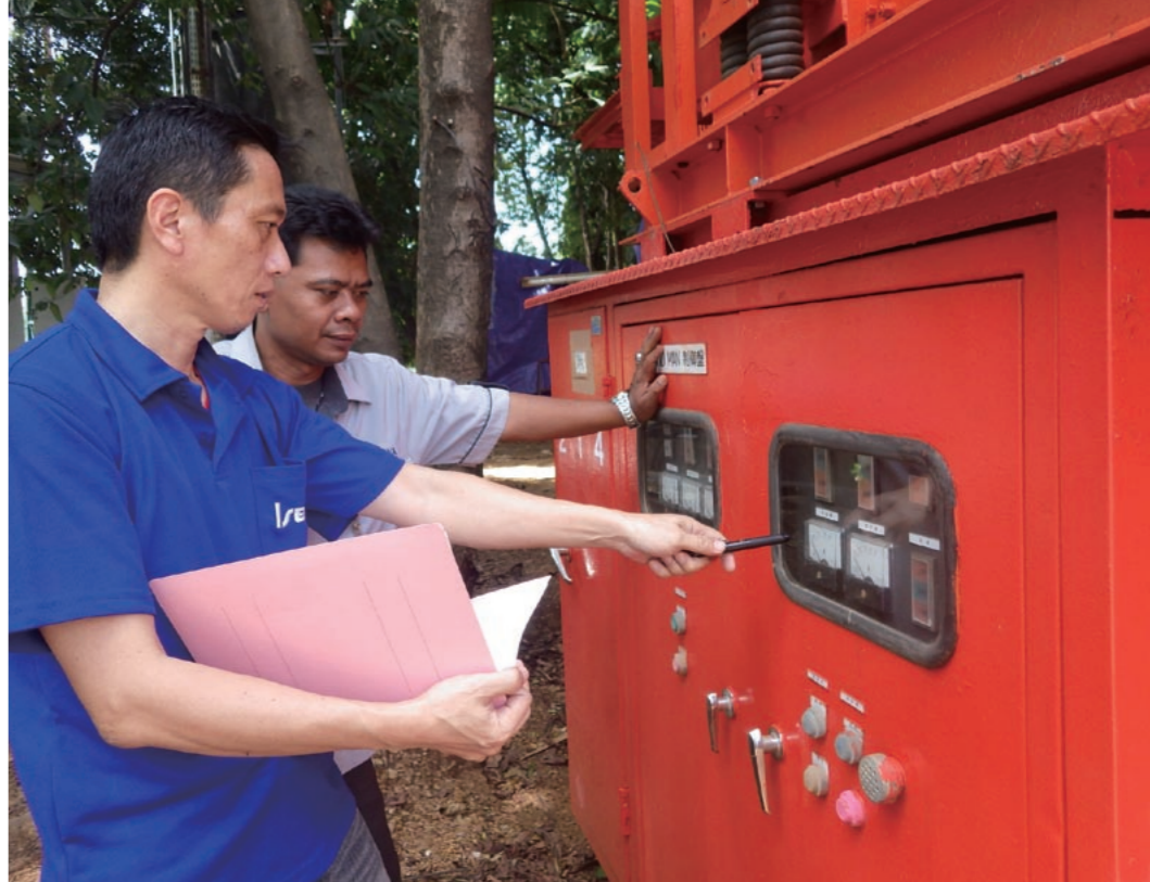
掘進機が稼動すると泥水が発生するため、それを処理する機械も同時に操作する。その方法を現地の技術者に指導する佐々木さん(手前)
