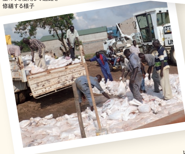
土のうを使用して道路を修繕する様子
