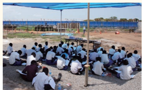
ナイル架橋の建設現場には、地元の小学生たちが社会科見学にも訪れる
