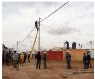
ザアタリ難民キャンプでの配線作業の様子
