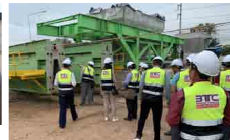
道路の建設現場に向いて、資材管理の説明を受ける。
