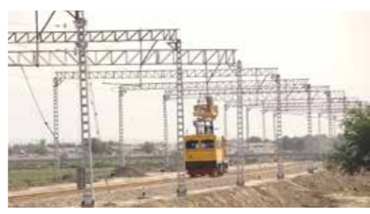
ウズベキスタンでの「カルシ-テルメス鉄道電化事業」では、従来のディーゼル方式よりも牽引力の高い電気方式への改良にJICAが協力。急勾配の山岳地帯を走る鉄道の輸送能力の向上に協力した。
