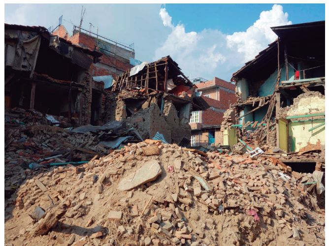
2015年地震でのネパールの被災状況 (撮影：JICA)
