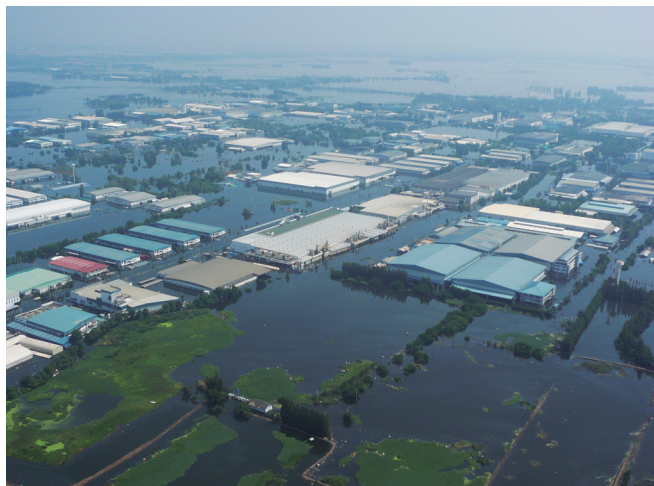
タイ大洪水による工業団地の被災（2011） （撮影：JICA）
