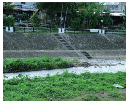
護岸につけられた階段が洪水時の水位を目視で測る基準になっている。 (写真提供:JICA)
