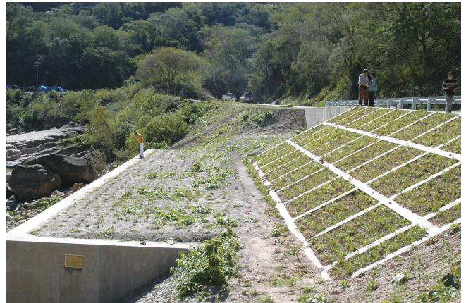
階段状の構造物による路肩補強と、修復された植栽を伴った路肩補強 (写真提供:フェルナンド・ハビエル・クエサル・オテロ/JICA)
