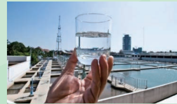
無償資金協力にて整備された ブンブレック浄水場 (JICA/Kenshiro Imamura)
