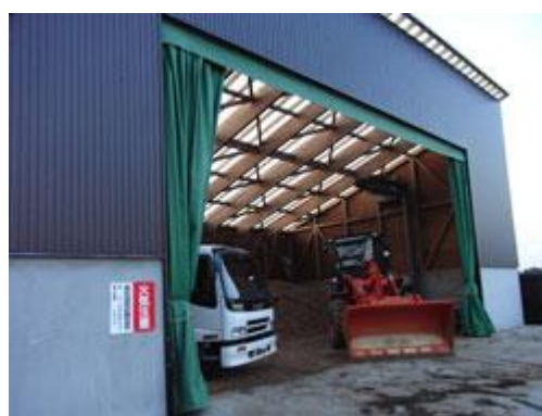
図 58 木質資源貯蔵施設
