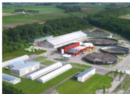
図 43 鹿追町環境保全センター（中鹿追）外観
