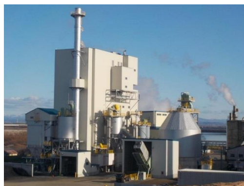
図 62 木質バイオマス発電所全景
