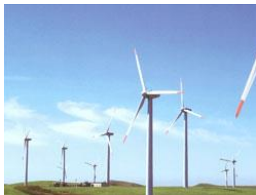
図 28 ユーラス宗谷岬ウインドファーム（提供：ユーラスエナジーホールディングス）
