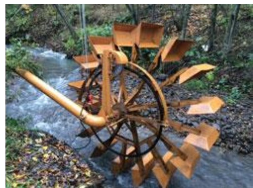
図 54 白鳥川小水力発電 1号機
