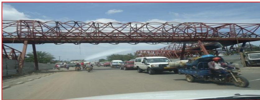
Daraja la watembea kwa miguu na upanuzi wa barabara uliofanywa na TANROADS Mkoa, mwaka 2013
