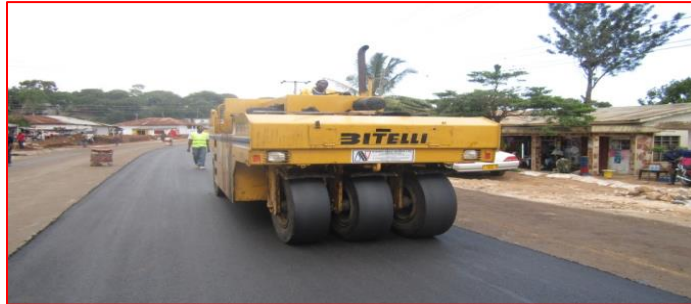
Ujenzi wa barabara ya Pasiansi – Buzuruga yenye km 7.32 mwaka 2012 kwa kiwango cha lami
