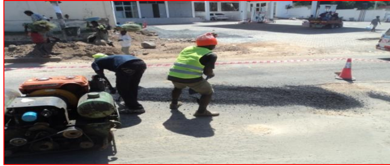
Ukarabati wa barabara ya Pamba Ukiendelea mwaka 2012 kwa fedha za Halmashauri
