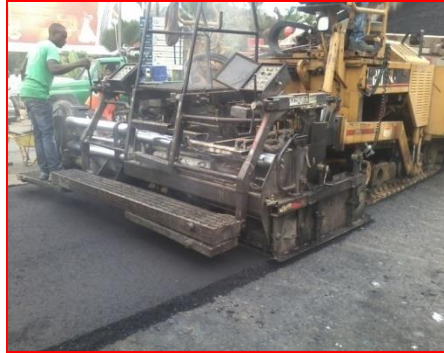
Ujenzi wa barabara ya Buzuruga – Pasiansi
