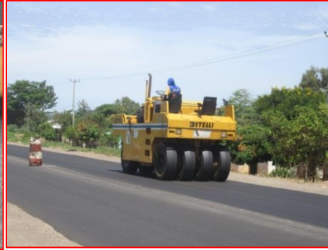
Uwekaji wa lami katika barabara ya Buzuruga – Pasiansi
