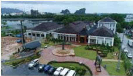
クラビ市アンダマン文化センター（中央）と、プロジェクトで建設したLocal Beverage Shop（左）
