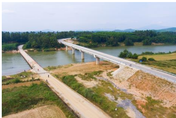
写真右：第二期国道・省道橋梁改修事業を通じて新しく建設されたディン橋 写真左：旧ディン橋
