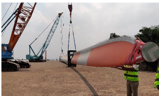
陸上風力発電所の建設予定地
