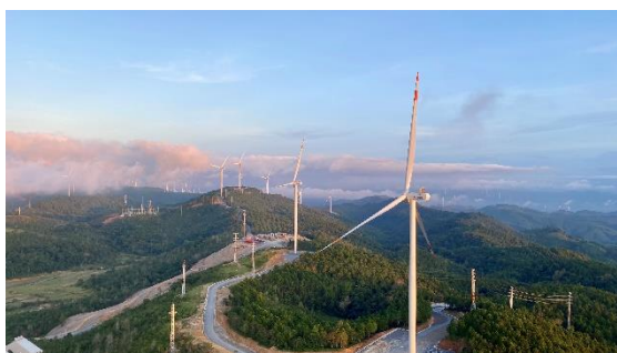
クアンチ省陸上風力発電事業 (写真提供: PowerConstructionJointStockCompanyNo. 1)
