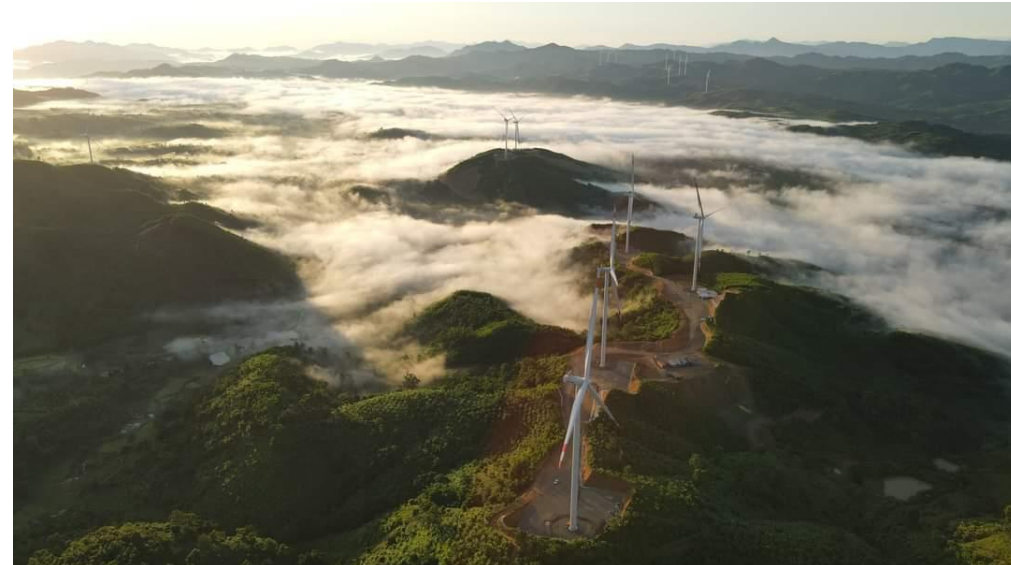
融資先のプロジェクトカンパニーにより建設された風力発電設備（写真提供：レノバ社）
