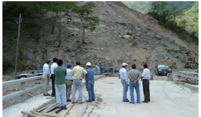
地滑り迂回工事視察 (写真提供:JICA)
