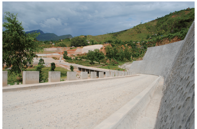
事業で整備された対象道路 (写真提供:JICA)
