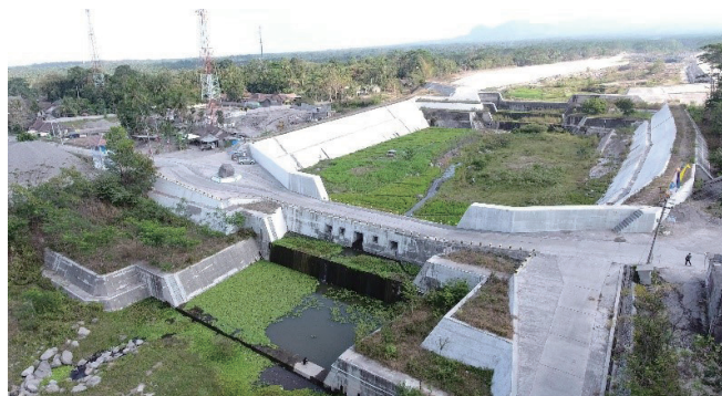
砂防堰堤と導流堤からなるサンドポケット (写真提供:八千代エンジニアリング株式会社)
