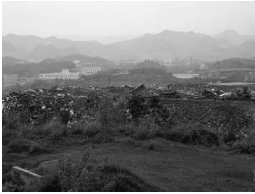
写真-1 高雁ごみ埋立処分場
