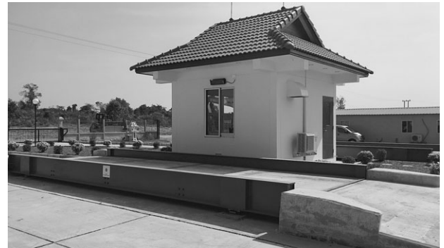
図-7 トラックスケール管理棟
