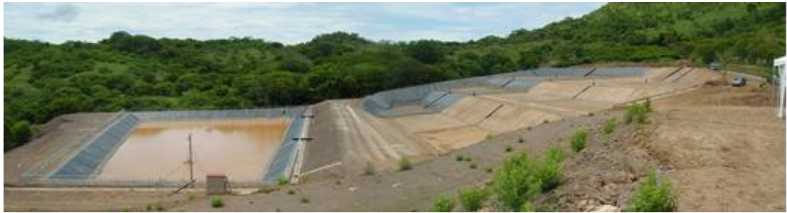
写真 27 新たに建設された衛生埋立処分場（フェーズ2）
