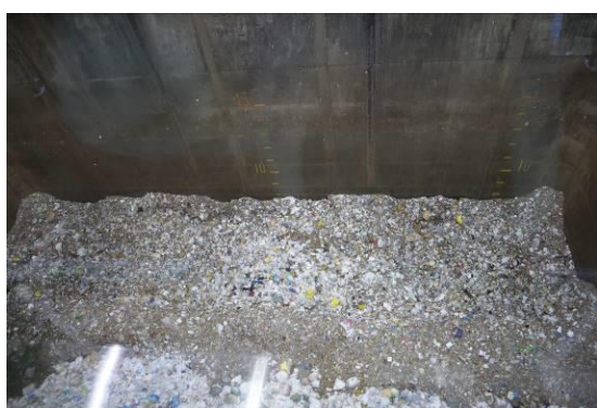
写真 4-36 ②ごみピット
