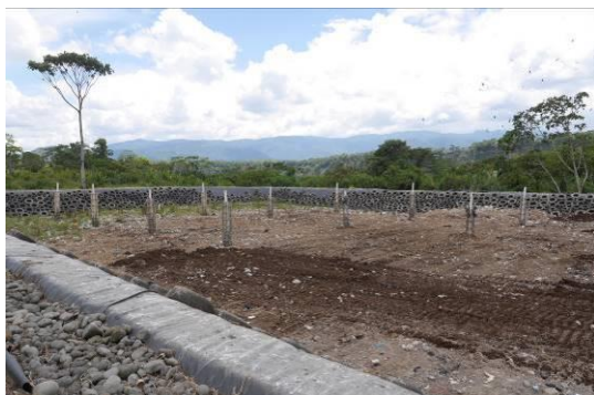
写真 4-72 福岡方式処分場外観
