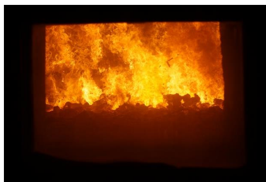
写真 4-39 ⑨焼却炉内でのごみ焼却の様子
