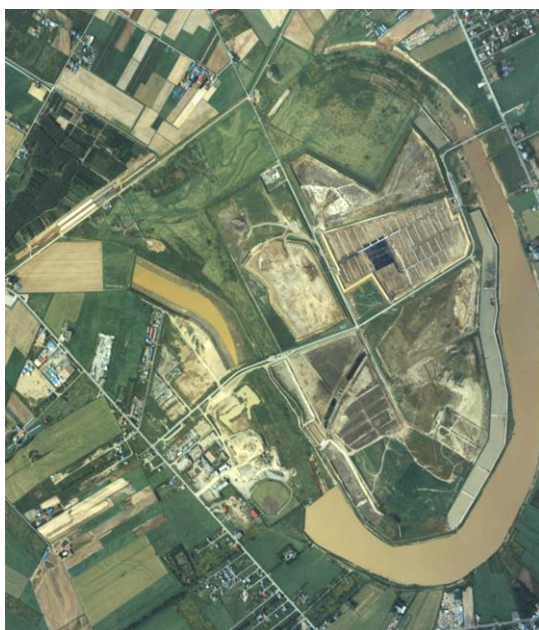
写真 4-74 モエレ処分場全景 (1985年撮影)
