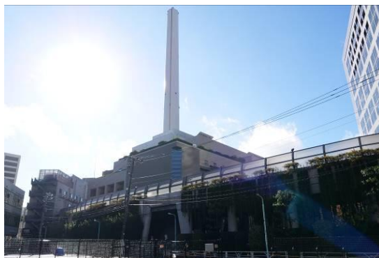
写真 4-30 渋谷清掃工場外観
