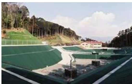
写真 4-64 南足柄市一般廃棄物最終処分場
