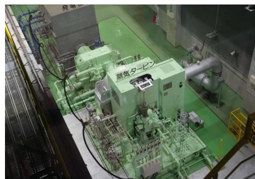
写真 4-43 蒸気タービン（杉並清掃工場）
