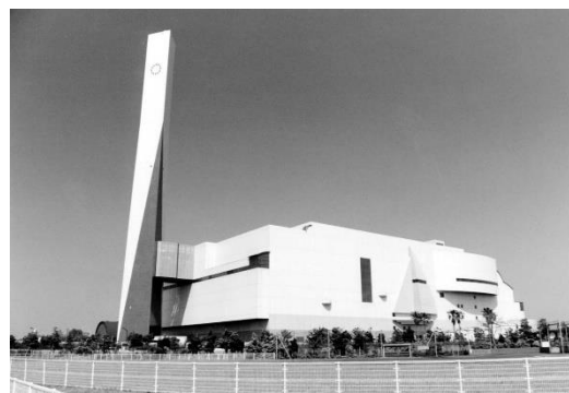
写真 4-28 新江東清掃工場（1998 年竣工）
