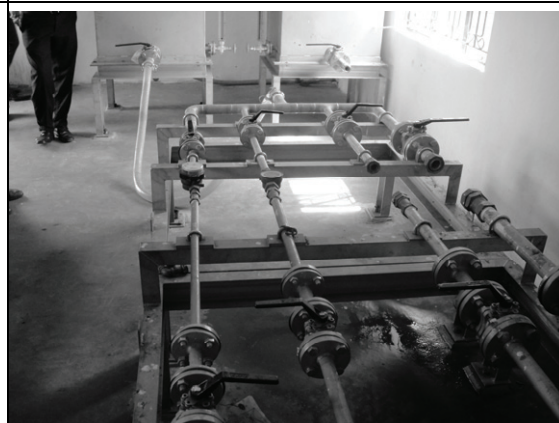
メルー上下水道信託会社(MEWASS)の浄水場にある水道メーターの検査装置
